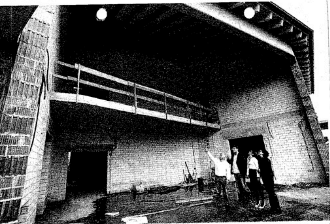
12,5 Meter hoch: Gerhart Fabi und Gunnar Mädel besichtigen mit ihren Mitarbeiterinnen Daniela Iorio und Nicole Daube (v. l.) den Rohbau. Der Blick aus geht von hier aus auf die Innenstadt. FOTOS: ANDREAS FRÜCKT
